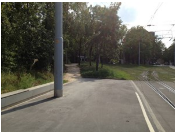
Falls mit Tram vom Zentrum kommend: Schotterweg links zu sehen.
