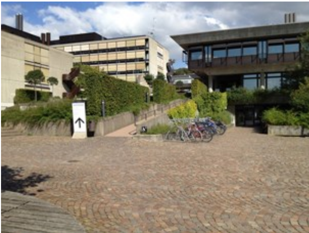
Rampe führt direkt zum Haupteingang. Bei der Rampe unten rechts Rollstuhl-Tafel ersichtlich.
