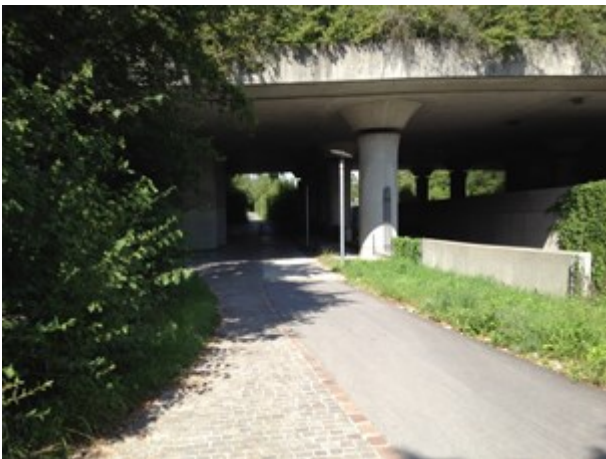
Danach Blick auf die Unterführung.
