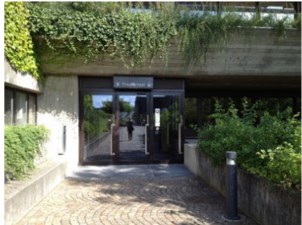
Rechts der Rampe führt ein Weg für Menschen im Rollstuhl zu diesem Eingang.
